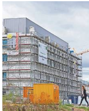
Der Krankenhaus-Rohbau steht schon.
