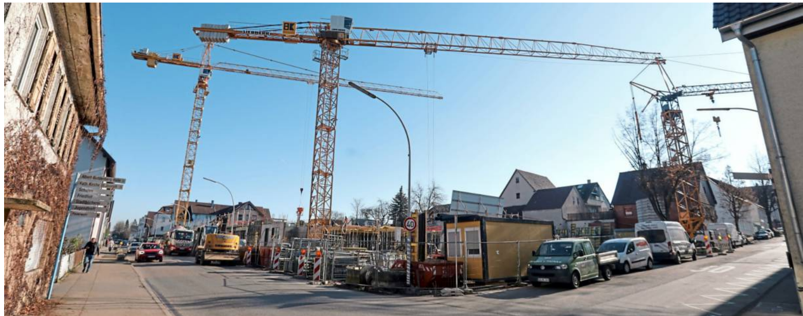
Das Gebäude für den Vollsortimenter samt Gewerbe und Wohnen darüber hat das Straßenniveau erreicht, das Schwierigste ist geschafft. Fotos: R. Theiss
